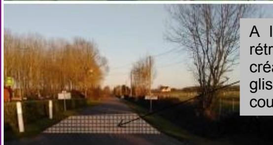
A l'entrée du village, en venant de Lalheue, un effet rétrécissement permettra de ralentir la circulation par la création d'un effet porte : pose de bordure type T2 et d'une glissière en bois et réalisation d'un enduit mono-couche de couleur.
